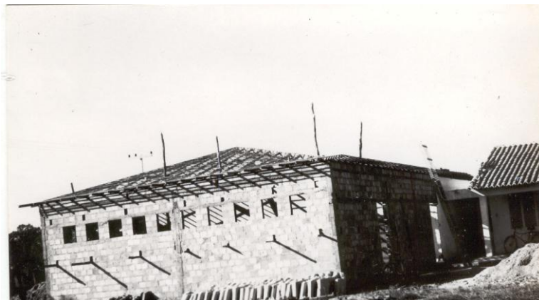
Foto 15: Reforma e ampliação do Ginásio Dom Severino em Água Branca – PI Fonte: Arquivo da CNEC-PI.
